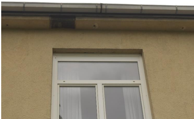
Slika šte. 5: fotografije razpok južnega obodnega zidu, zgoraj v pritličju ob JV vogalu, spodaj levo pri oknu v nadstropju in spodaj desno v JV vogalu pod steho
